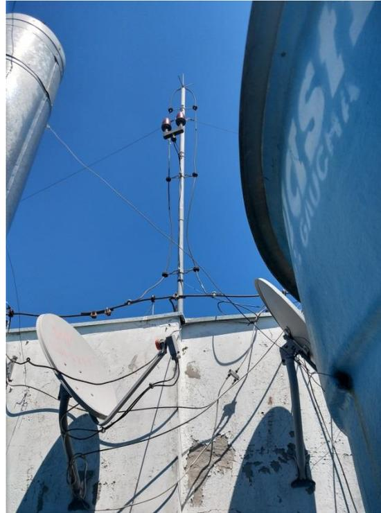
Sobreposição de sistemas na cobertura e falta de manutenção das partes.
