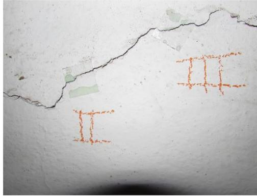
Teste de corrosão com placas de vidro e fissurômetro
